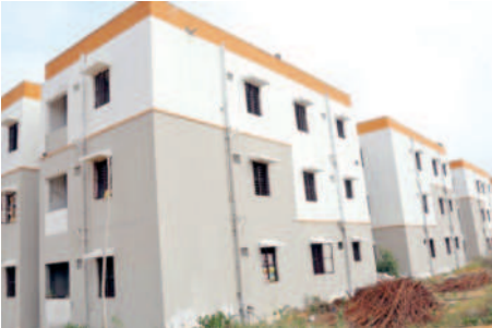
నిర్మాణ దశలో ఉన్న డబుల్ బెడ్‌రూం ఇళ్లు
